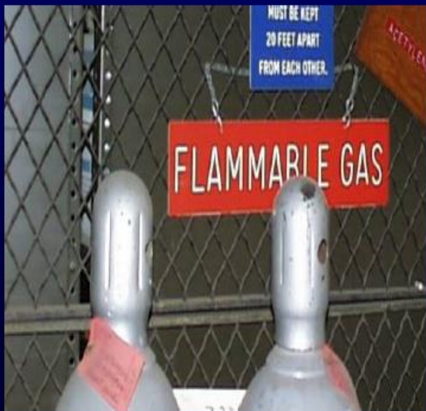
可燃钢瓶的正确隔离
